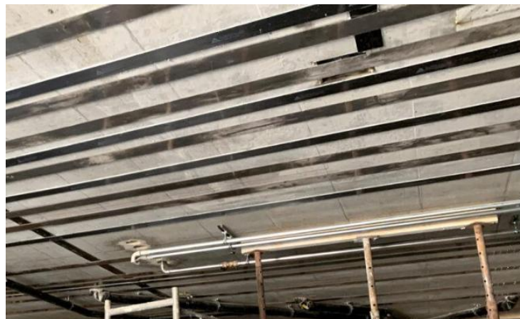
Abbildung 6 Technische Erneuerung einer Stahlbetondecke mit Re-plates
