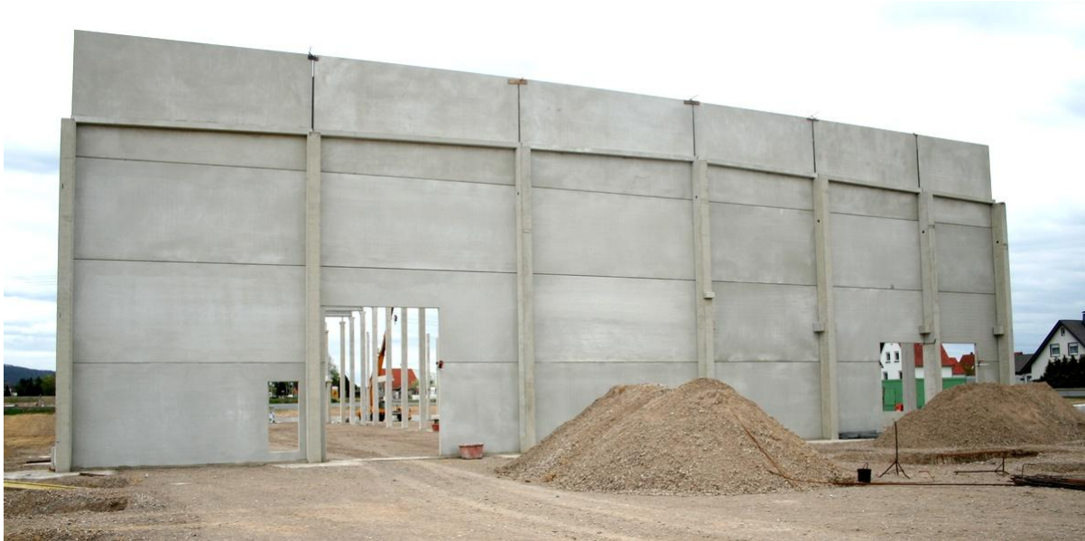
Abbildung 42 Aufbau einer Halle mit Betonfertigteilen [51]
