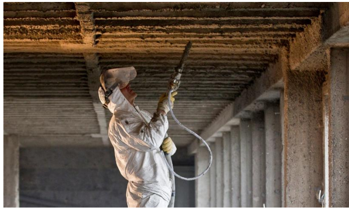
Abbildung 4 Instandsetzung von Betonbauteilen im Spritzbetonverfahren
