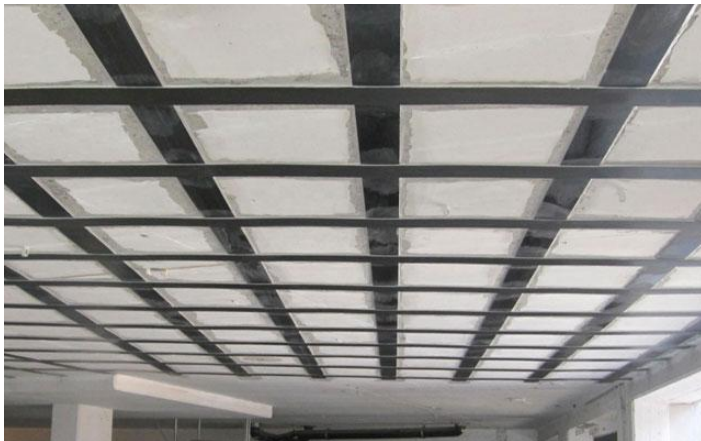
Abbildung 33 Nachträglich aufgebrachte Carbonlamellen [41]
