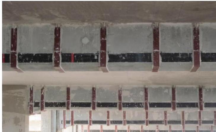
Abbildung 5 Technische Erneuerung von Stahlbetonträgern mit Carbonlamellen
