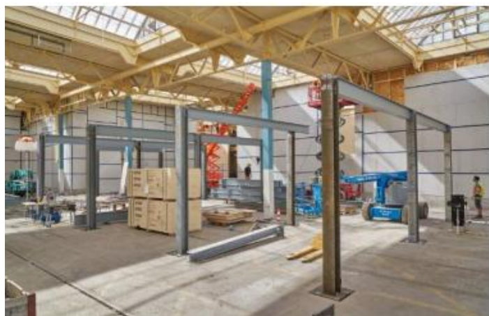
Abbildung 3 Galerietragwerk mit wiederverwendeten Stahlbauteilen
