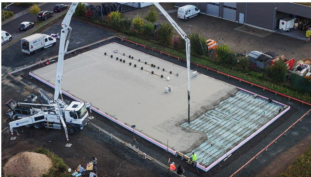
Abbildung 43 Einbau einer Bodenplatte [52]
