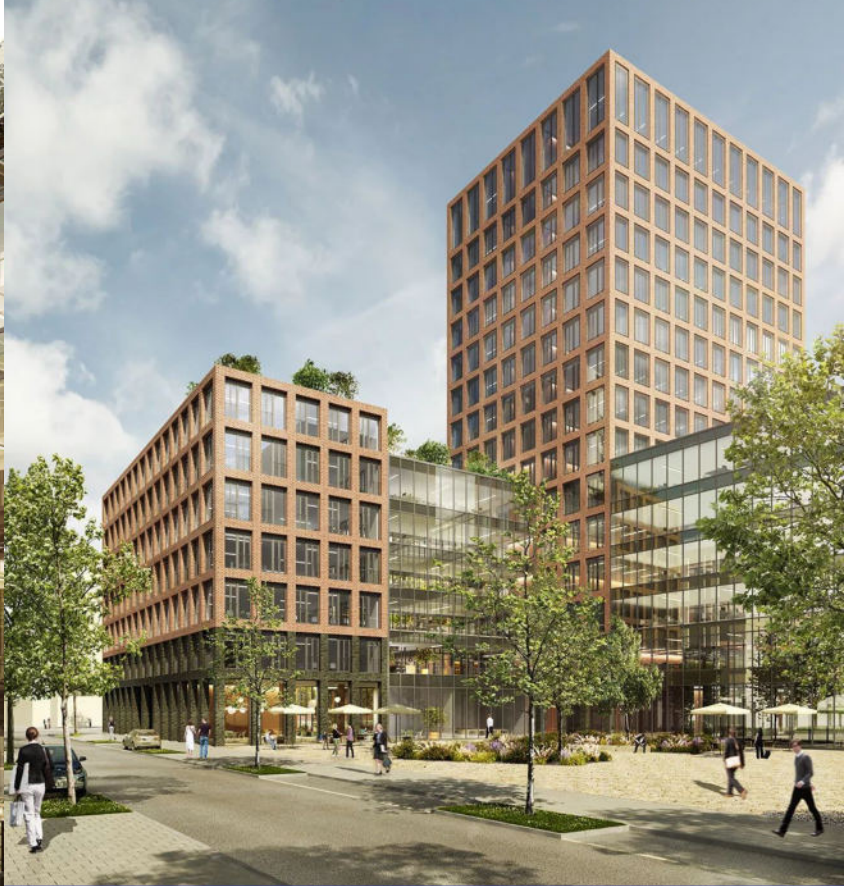
ReUse-Ziegel-Fassade ELBBRÜCKENQUARTIER 101 HAMBURG
